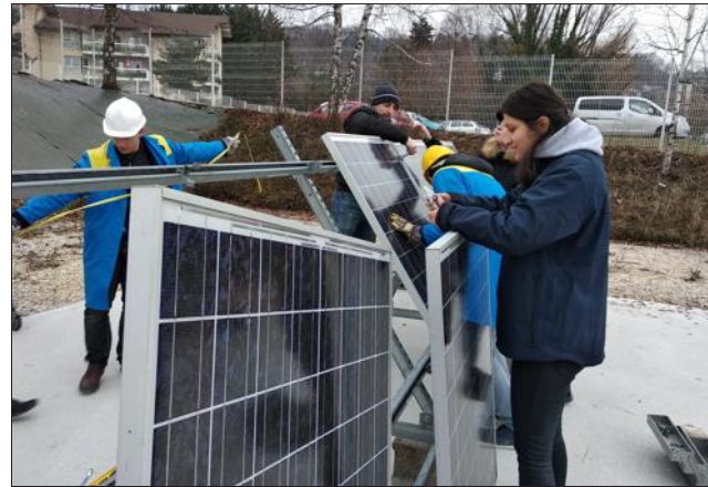
Quatorze étudiants ont installé la plateforme qui fournit l'électricité dans le lycée. Photo Le DL/P-L.Z.
